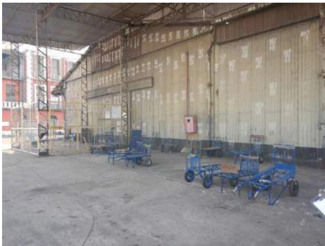
FIGURA 224 – REGISTROS DE TOMBAMENTO NOS ARMAZÉNS Nº 0-4. FONTE: UNILIVRE, SETEMBRO, 2023.
