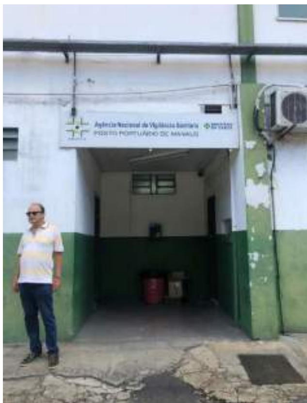
FIGURA 116 – SALA DA ANVISA NA ÁREA DE ESCRITÓRIOS DIVERSOS. FONTE: UNILIVRE, MAIO, 2023.
