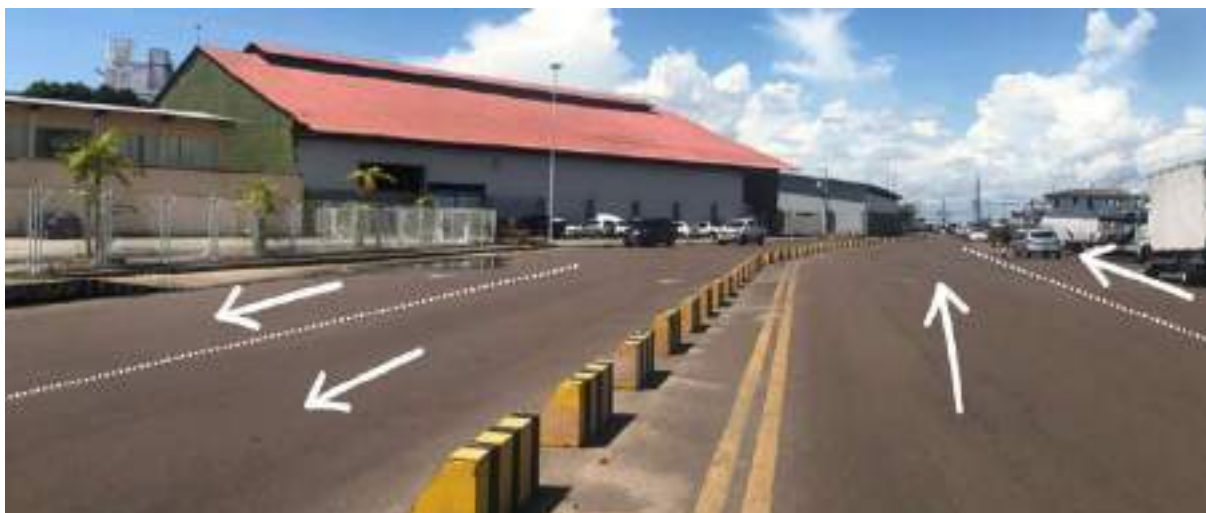
FIGURA 200 – IMAGEM DA BARREIRA DIVISÓRIA NAS FAIXAS DA PISTA DE ROLAMENTO NO SENTIDO DE SAÍDA DO PORTO. FONTE: UNILIVRE, MAIO, 2023.
