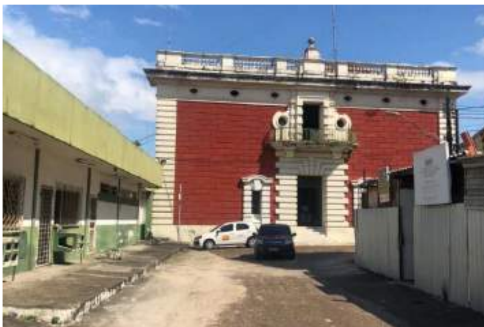
FIGURA 8 – PRÉDIO DE ADMINISTRAÇÃO DO PPOM. FONTE: UNILIVRE, MAIO, 2023.
