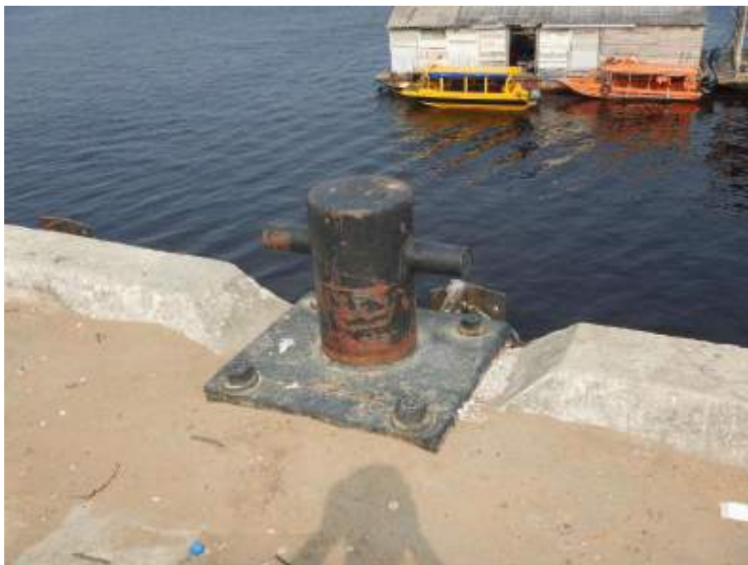
FIGURA 33 – CABEÇO DE AMARRAÇÃO DO CAIS DA PLATAFORMA MALCHER. FONTE: UNILIVRE, SETEMBRO, 2023.
