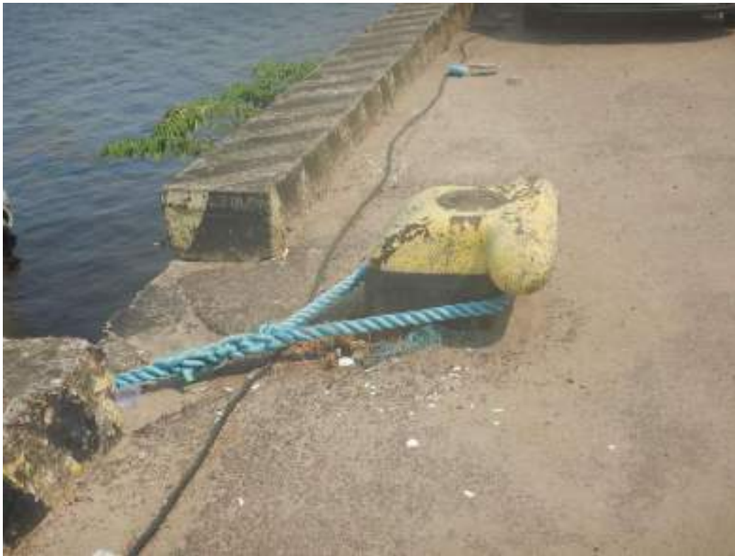
FIGURA 28 – CABEÇO DE AMARRAÇÃO DO CAIS PAREDÃO. FONTE: UNILIVRE, SETEMBRO, 2023.
