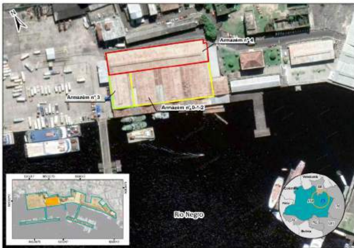
FIGURA 93 – ARMAZÉNS Nº 0-4, VISTA AÉREA. FONTE: GOOGLE EARTH, 2023.
