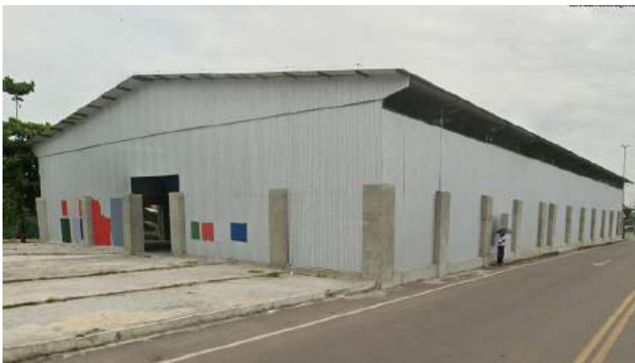
FIGURA 140 – ARMAZEM Nº 20-E VISTA DA PISTA DE ROLAMENTO. FONTE: UNILIVRE, SETEMBRO, 2023.
