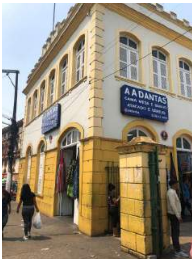
FIGURA 135 – ANTIGA CASA DE TRAÇÃO, VISTA DA RUA MARQUES DE SANTA CRUZ. FONTE: UNILIVRE, SETEMBRO, 2023.
