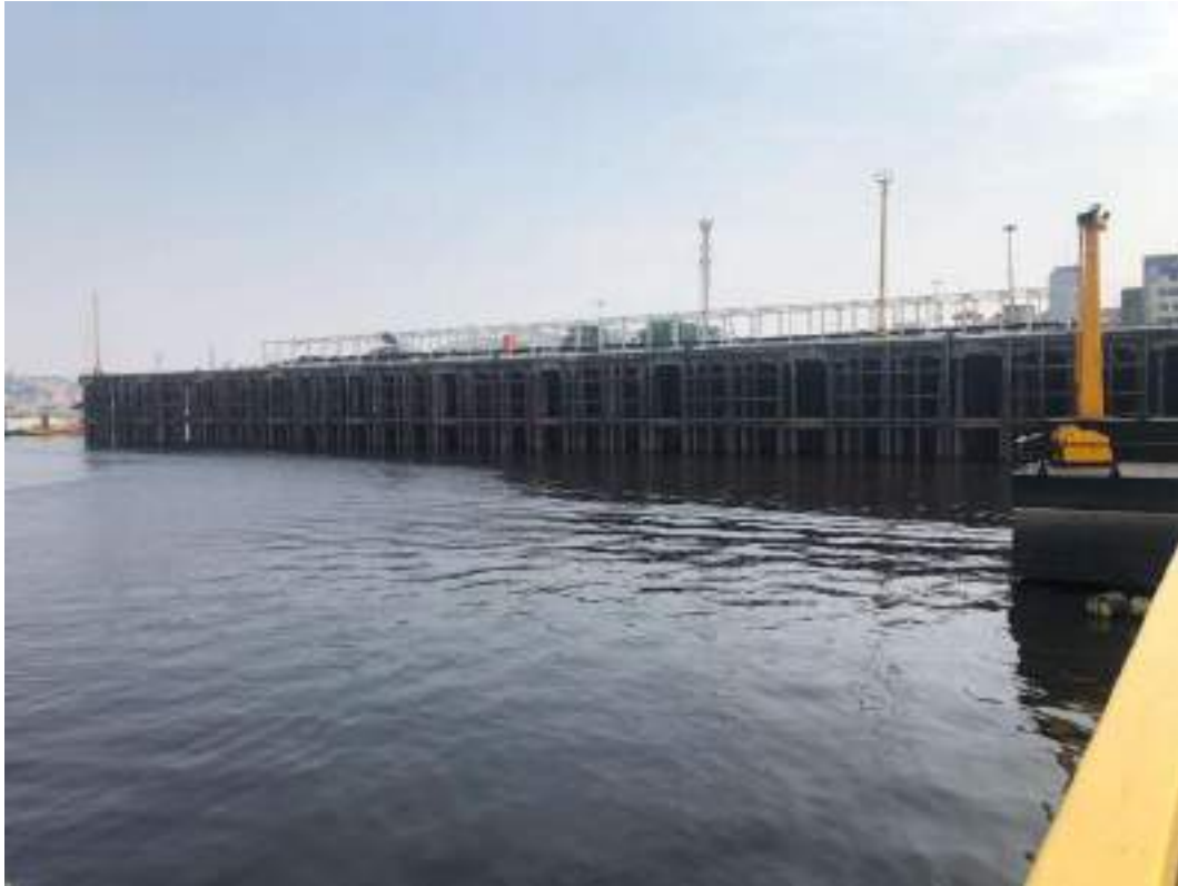
FIGURA 31 – VISTA FRONTAL DA PLATAFORMA MALCHER E CONJUNTO DE DEFENSAS. FONTE: UNILIVRE, SETEMBRO, 2023.
