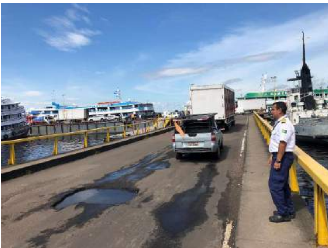
FIGURA 265 – SITUAÇÃO ATUAL DA PONTE DE ACESSO AO CAIS FLUTUANTE DAS TORRES. FONTE: UNILIVRE, MAIO, 2023.
