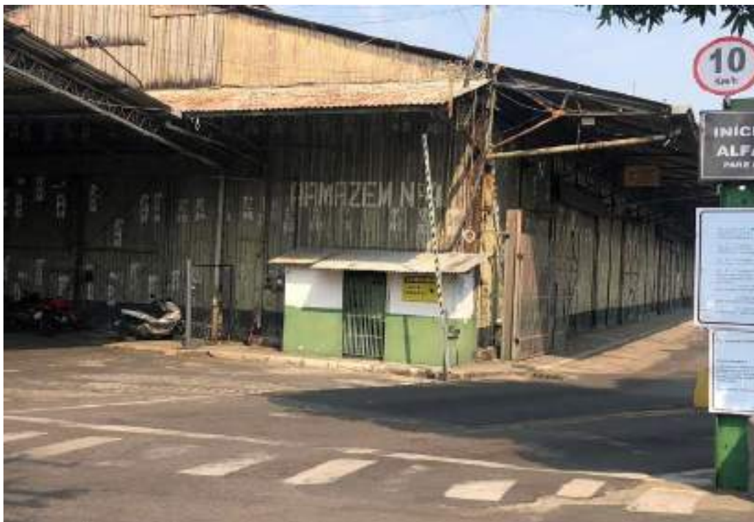
FIGURA 189 – SUBESTAÇÃO DE ENERGIA AO LADO DO P9. FONTE: UNILIVRE, SETEMBRO, 2023.
