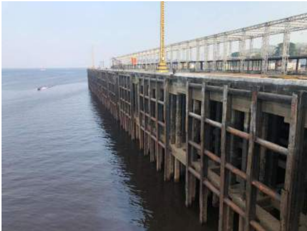
FIGURA 32 – CONJUNTO DE DEFENSAS DO CAIS DA PLATAFORMA MALCHER. FONTE: UNILIVRE, SETEMBRO, 2023.
