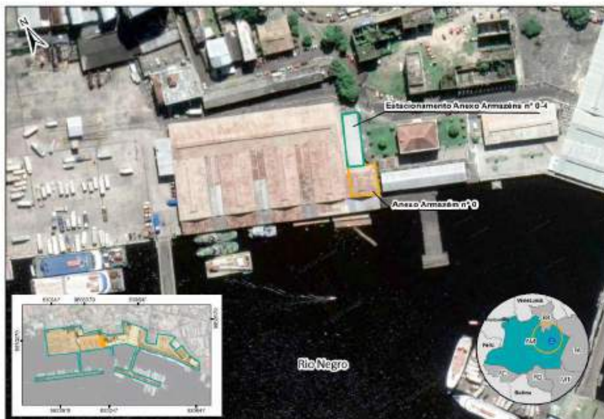
FIGURA 146 – VISTA AÉREA DO ANEXO DO ARMAZEM Nº 0. FONTE: UNILIVRE, SETEMBRO, 2023.
