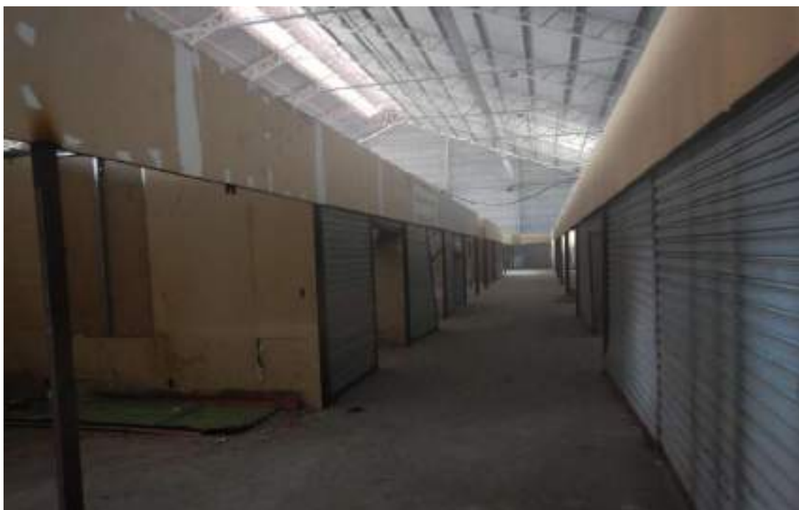
FIGURA 144 – INTERIOR DO ARMAZÉM Nº 23. FONTE: UNILIVRE, SETEMBRO, 2023.
