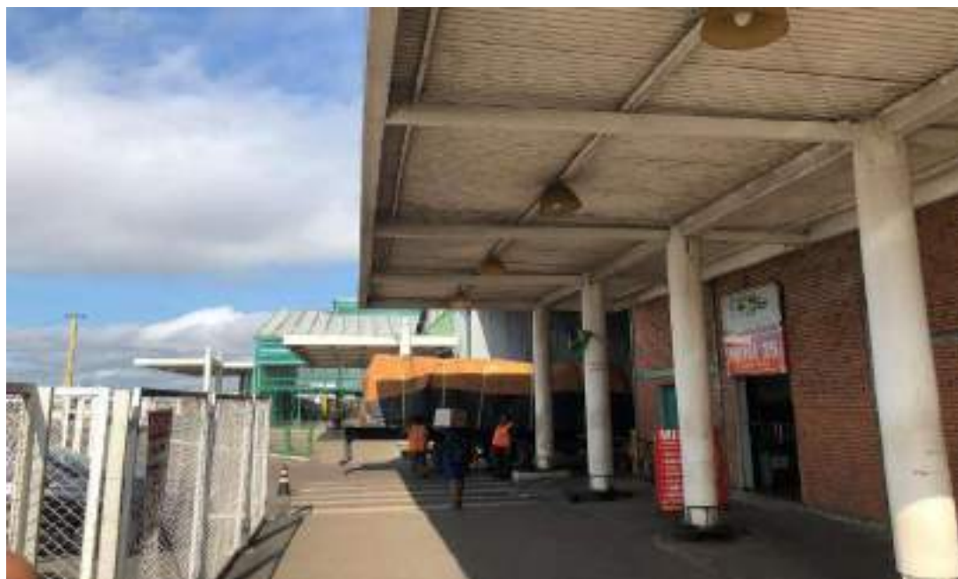
FIGURA 57 – ACESSO DE PEDESTRES AO PORTO. FONTE: UNILIVRE, MAIO, 2023.
