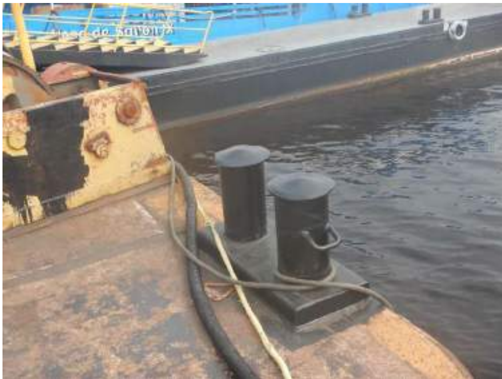
FIGURA 22 – CABEÇOS DE AMARRAÇÃO DO CAIS DAS TORRES. FONTE: UNILIVRE, SETEMBRO, 2023.
