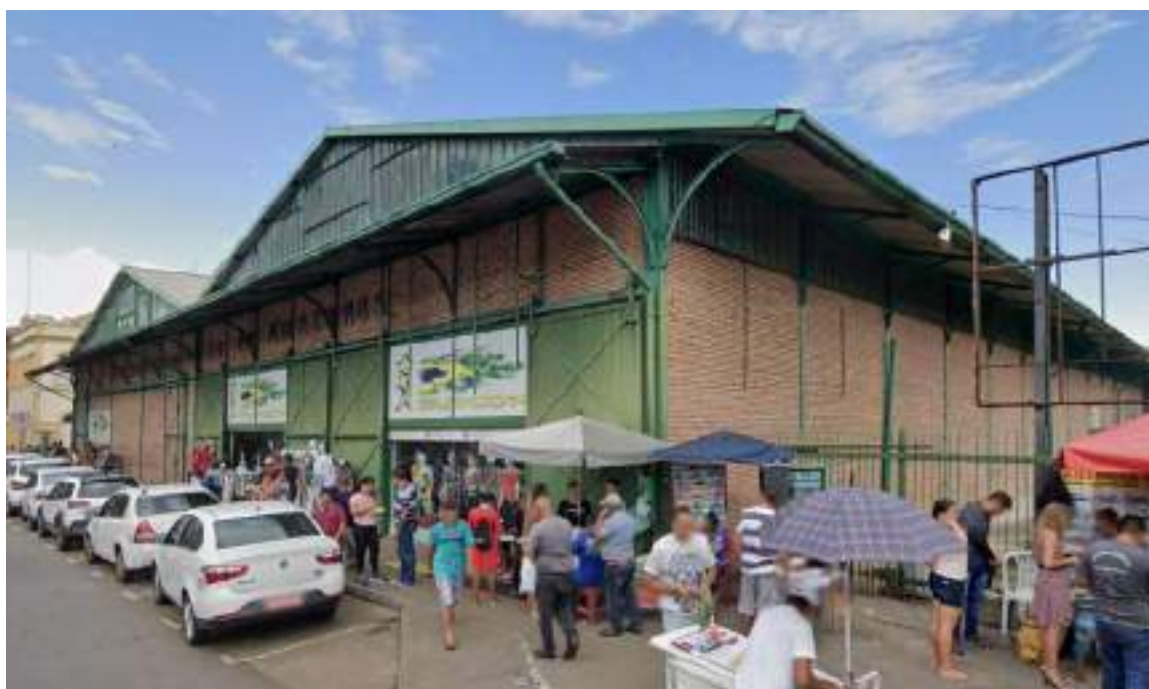
FIGURA 137 – ARMAZÉM Nº 10-A, VISTA DA AV. MARECHAL FLORIANO PEIXOTO. FONTE: UNILIVRE, MAIO, 2023.
