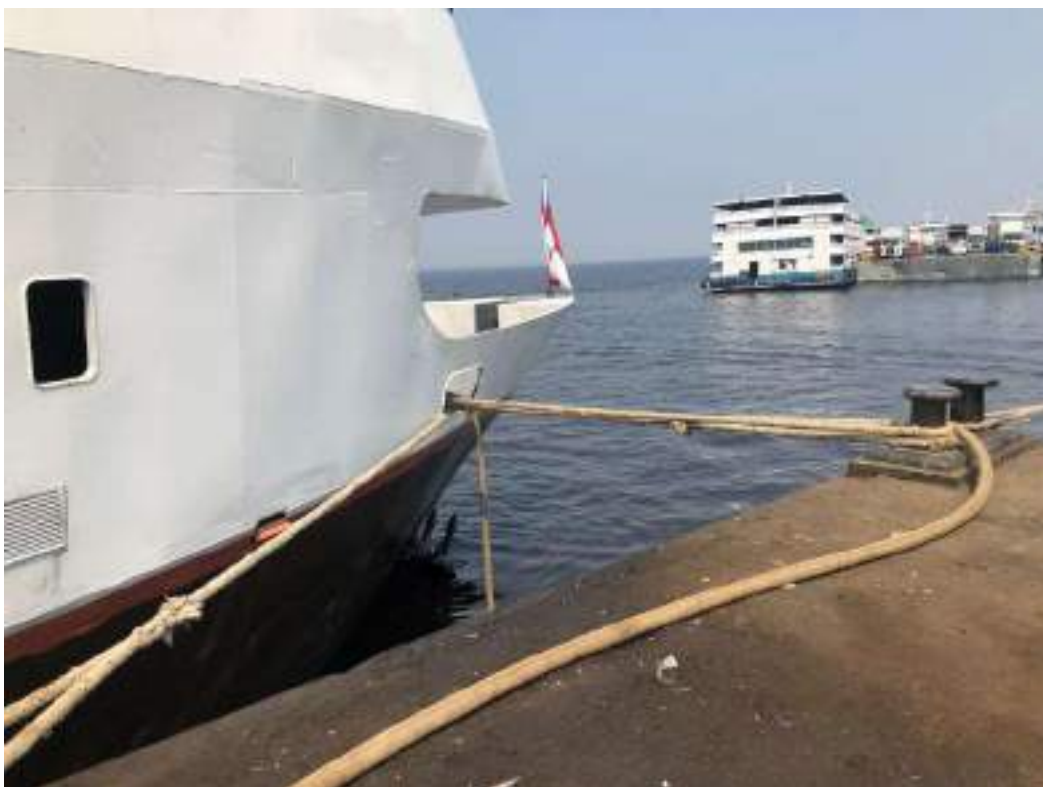
FIGURA 17 – CABEÇO DE AMARRAÇÃO DO CAIS FLUTUANTE ROADWAY. FONTE: UNILIVRE, SETEMBRO, 2023.
