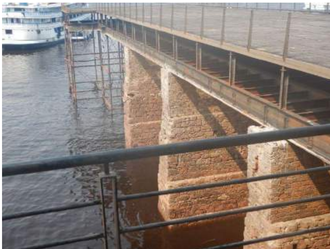
FIGURA 161 – ESTRUTURA DE SUPORTE DO TRAPICHE 15 DE NOVEMBRO. FONTE: UNILIVRE, SETEMBRO, 2023.
