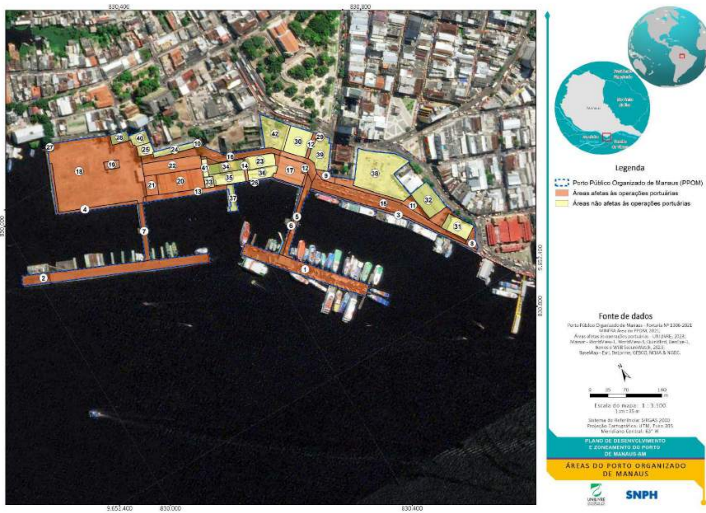
FIGURA 108 – MAPA DAS ÁREAS DO PORTO ORGANIZADO DE MANAUS DISPONÍVEIS PARA ARRENDAMENTOS – CENÁRIOS FUTUROS.
