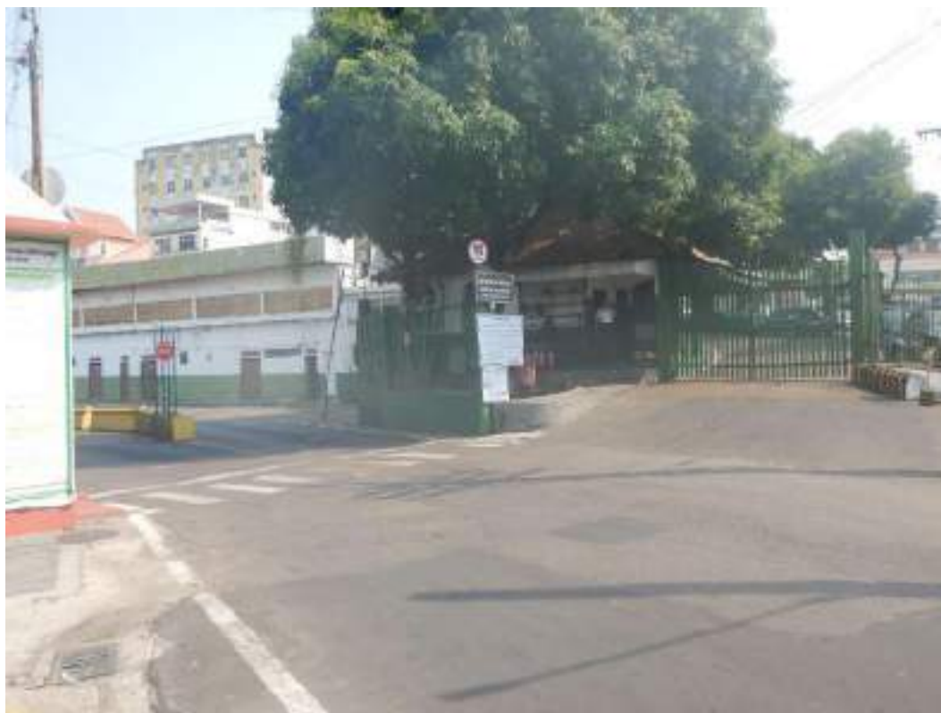
FIGURA 53 – VISTA DA PARTE INTERNA DO POSTO DE CONTROLE P-9. FONTE: UNILIVRE, SETEMBRO, 2023.
