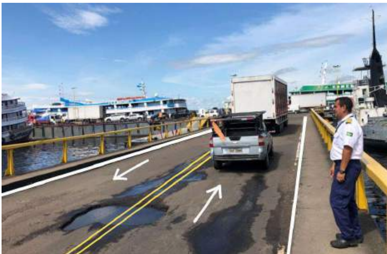
FIGURA 206 – VIA DE ACESSO AO FLUTUANTE TORRES. FONTE: UNILIVRE, MAIO, 2023.
