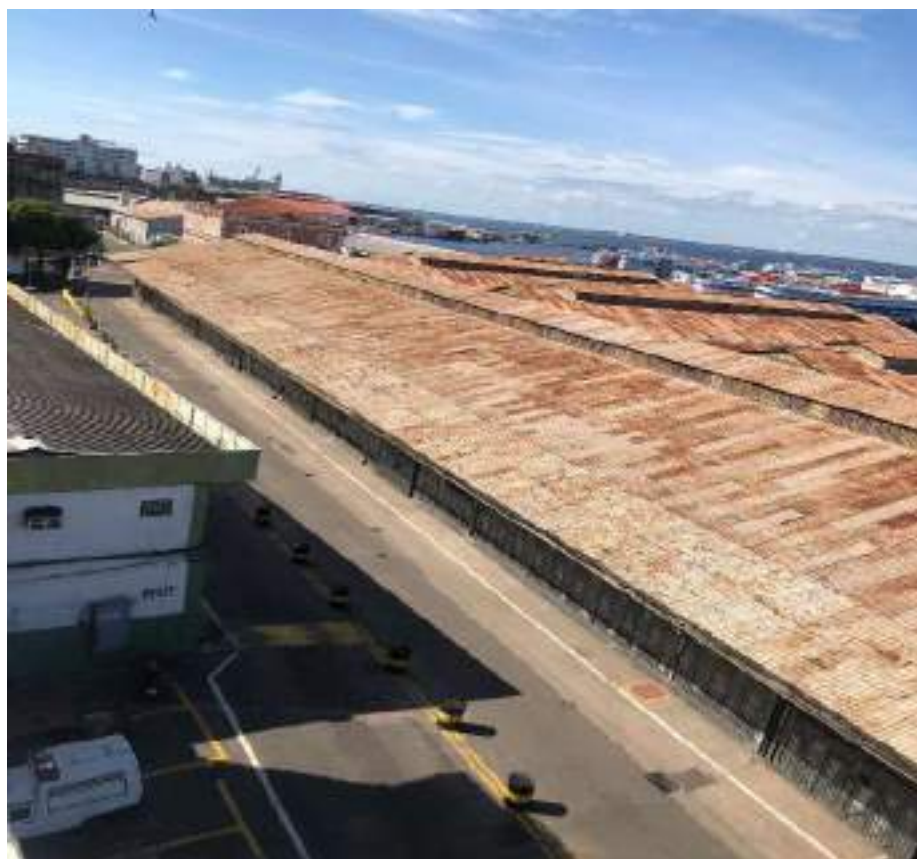
FIGURA 74 – VIA LATERAL DO ARMAZÉM Nº 4. FONTE: UNILIVRE, MAIO, 2023.
