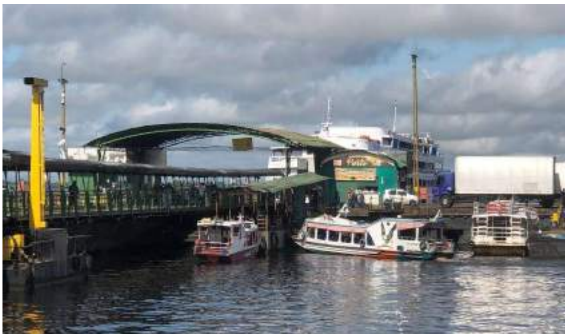
FIGURA 14 – CAIS FLUTUANTE ROADWAY E PONTE DE ACESSO. VISTA DA ESTAÇÃO DE PASSAGEIROS (ARMAZÉM Nº 10). FONTE UNILIVRE, MAIO, 2023.
