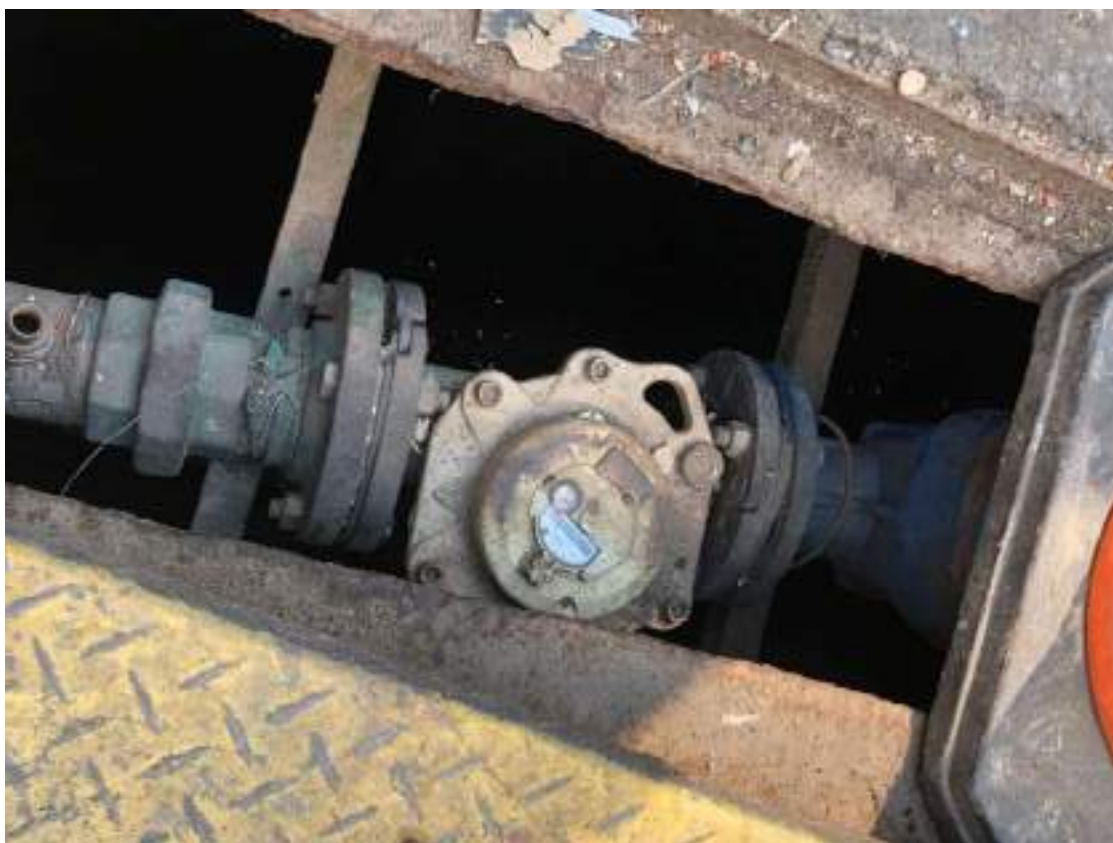
FIGURA 192 – HIDRÔMETRO LOCALIZADO NO CAIS ROADWAY. FONTE: UNILIVRE, SETEMBRO, 2023.
