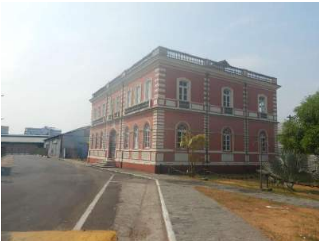
FIGURA 66 – CAMINHO ALTERNATIVO DE PEDESTRES: SEGMENTO A FRENTE DO ANTIGO PRÉDIO DO TESOURO PÚBLICO.
