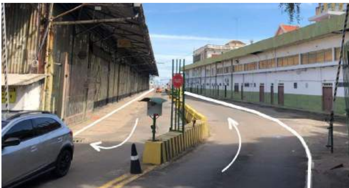
FIGURA 203 – INÍCIO DA VIA LATERAL DO ARMAZÉM Nº 4, COM ACESSO À PLATAFORMA MALCHER E AO FLUTUANTE TORRES. FONTE: UNILIVRE, MAIO, 2023.
