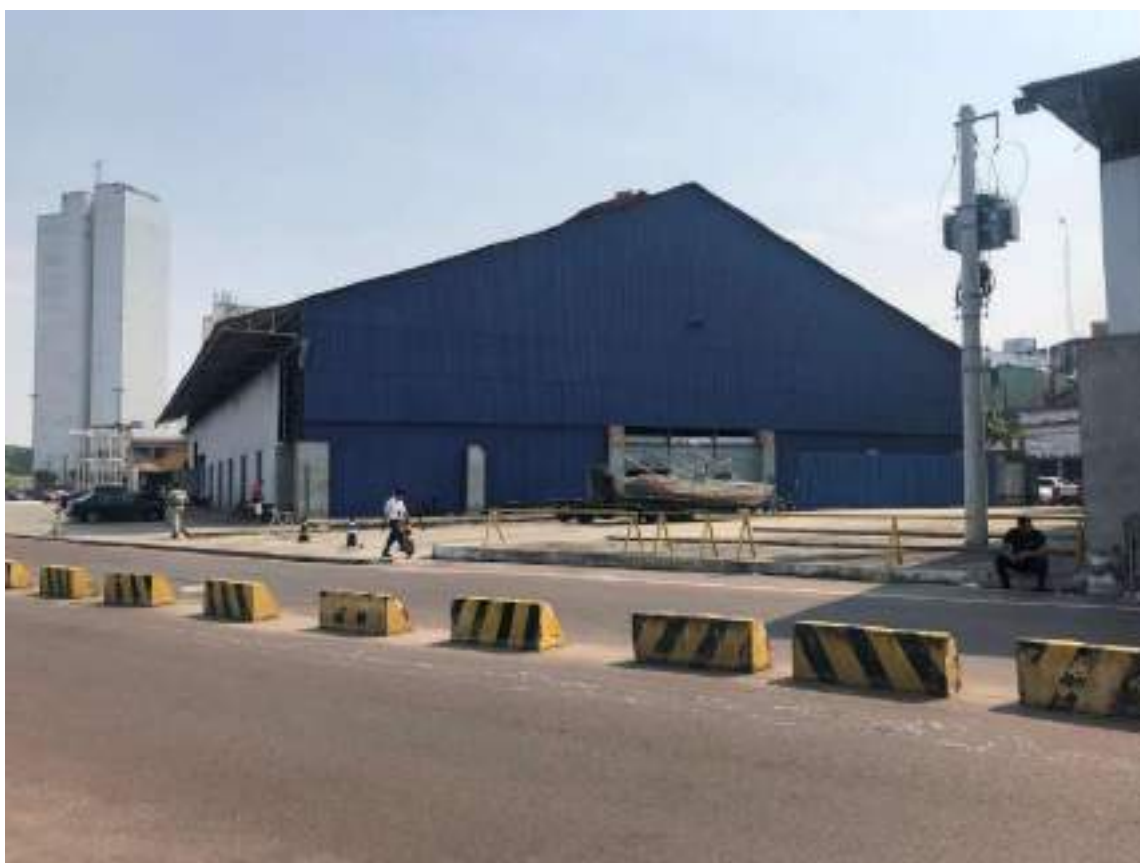
FIGURA 143 – ARMAZÉM Nº 23, VISTA PISTA DE ROLAMENTO. FONTE: UNILIVRE, SETEMBRO, 2023.
