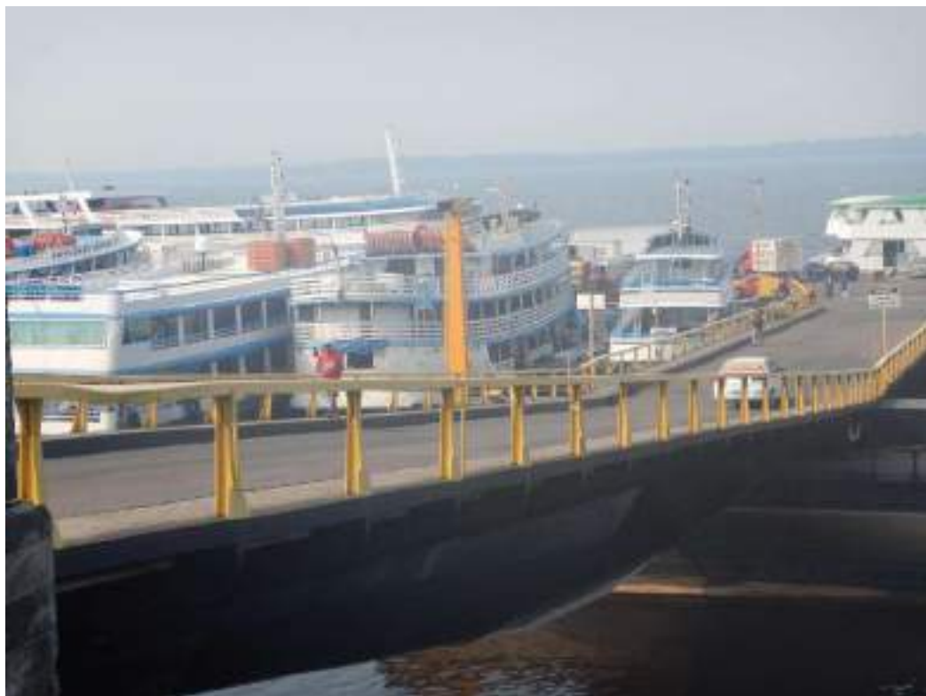
FIGURA 43 – PONTE DE ACESSO AO CAIS FLUTUANTE DAS TORRES. FONTE: UNILIVRE, SETEMBRO, 2023.
