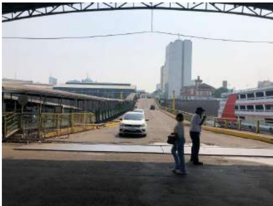
FIGURA 35 – ACESSO RODOVIÁRIO AO FLUTUANTE ROADWAY. FONTE: UNILIVRE, SETEMBRO, 2023.
