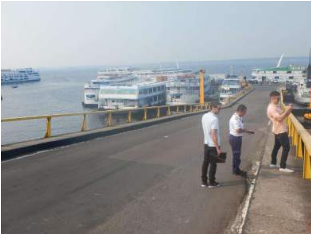
FIGURA 42 – PONTE DE ACESSO AO CAIS FLUTUANTE DAS TORRES. FONTE: UNILIVRE, SETEMBRO, 2023.
