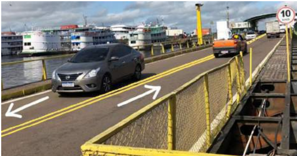
FIGURA 201 – IMAGEM DA VIA DE ACESSO AO FLUTUANTE ROADWAY. FONTE: UNILIVRE, MAIO, 2023.
