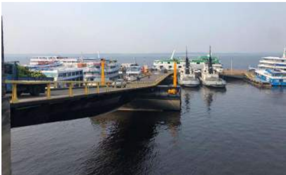
FIGURA 19 – CAIS DAS TORRES E PONTE FLUTUANTE VISTA DA PLATAFORMA MALCHER. FONTE: UNILIVRE, SETEMBRO, 2023.
