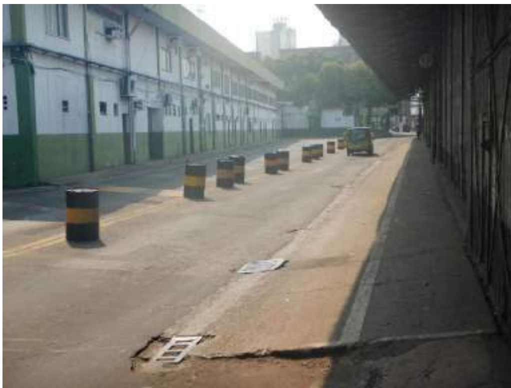
FIGURA 67 – CAMINHO ALTERNATIVO DE PEDESTRES: SEGMENTO NA VIA LATERAL DO ARMAZÉM Nº 4. FONTE: UNILIVRE, SETEMBRO, 2023.
