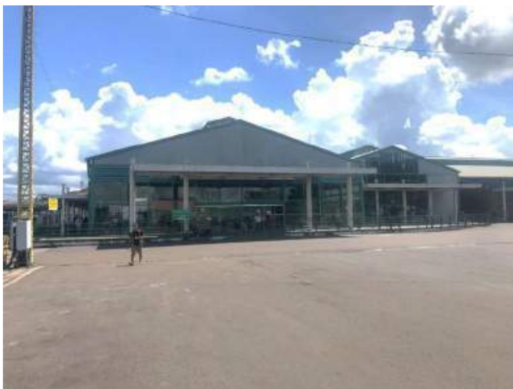
FIGURA 77 – ARMAZÉM Nº 10. VISTA DA PISTA DE ROLAMENTO. FONTE: UNILIVRE, MAIO, 2023.
