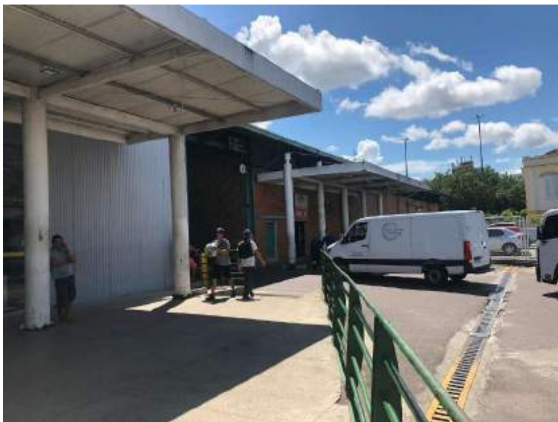
FIGURA 58 – ACESSO DE PEDESTRES AO PORTO. FONTE: UNILIVRE, MAIO, 2023.
