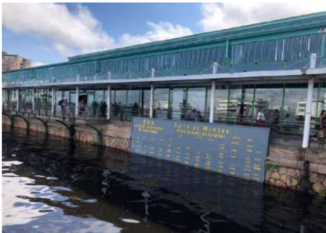
FIGURA 76 – ARMAZÉM Nº 10 E PAINEL COM REGISTRO DOS MÁXIMOS NÍVEIS DE ÁGUA DO RIO NEGRO. VISTA DA PONTE DE ACESSO AO ROADWAY. FONTE: UNILIVRE, MAIO, 2023.
