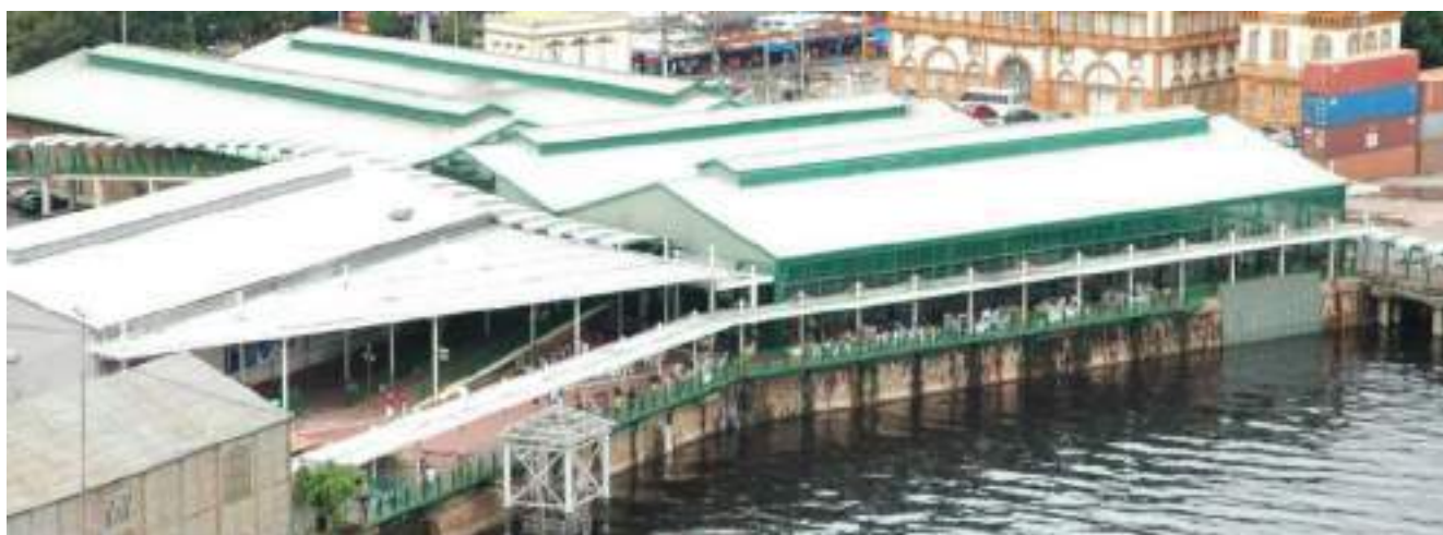
FIGURA 269 – ÁREA ANEXA AO TERMINAL DE PASSAGEIROS ANTES DAS OBRAS DA PRAÇA DOS INGLESES.
