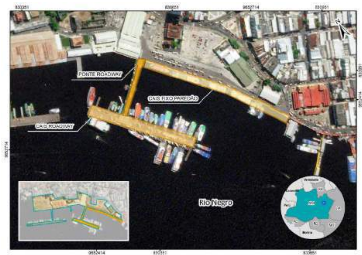
FIGURA 24 – CAIS FLUTUANTE ROADWAY, PONTE FLUTUANTE DE ACESSO AO ROADWAY E CAIS FIXO PAREDÃO.
