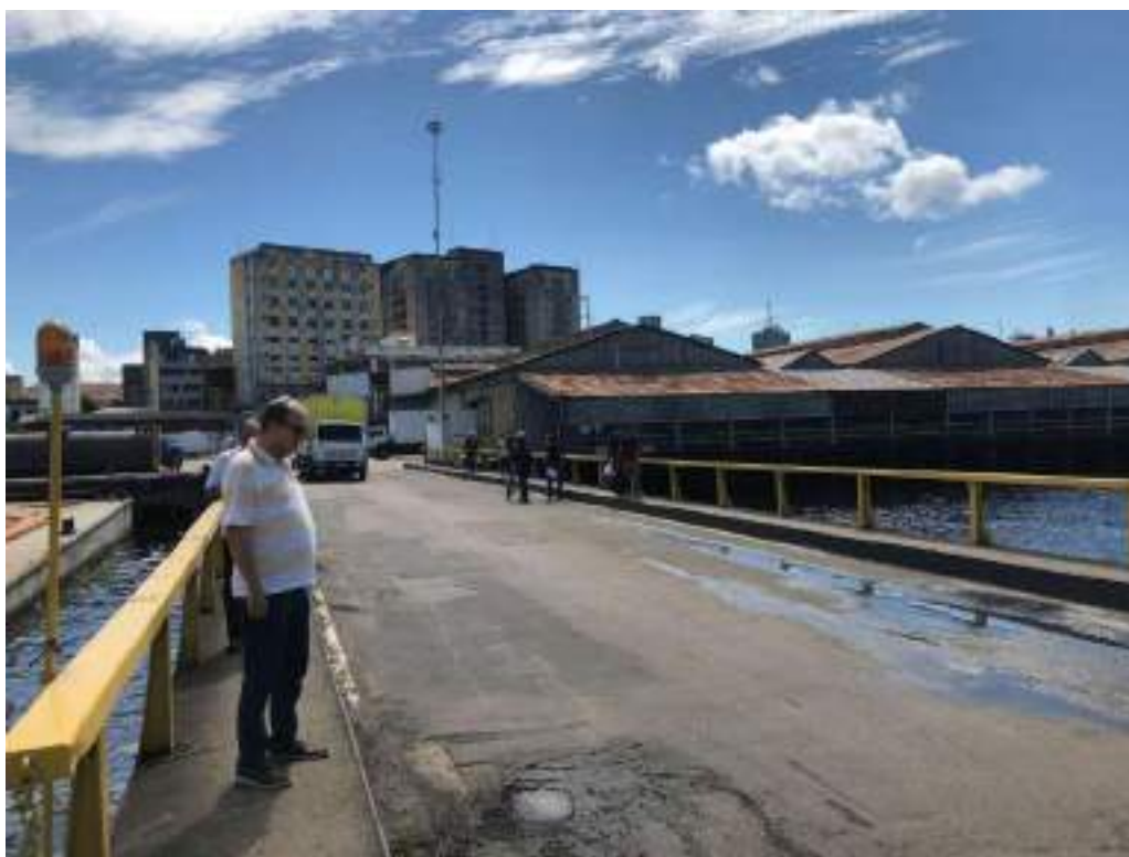
FIGURA 41 – PONTE DE ACESSO AO CAIS FLUTUANTE DAS TORRES FONTE: UNILIVRE, MAIO, 2023.
