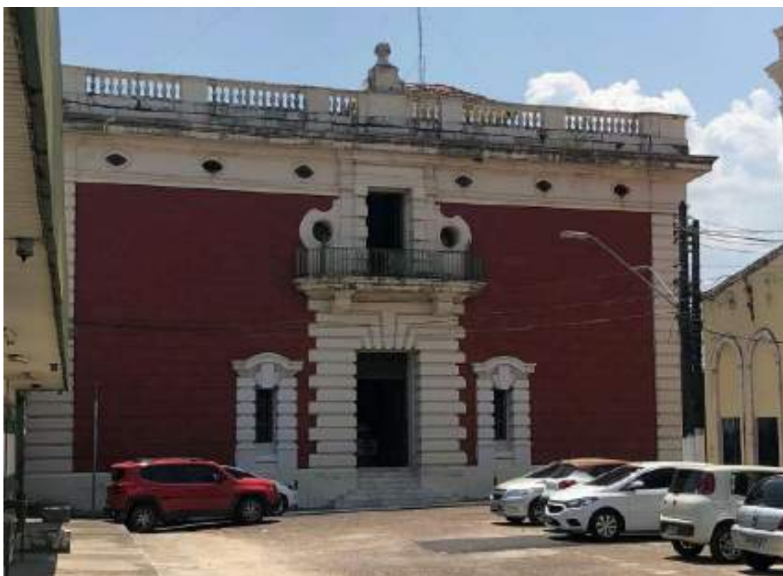
FIGURA 118 – PRÉDIO DA ADMINISTRAÇÃO CENTRAL, VISTA DA RUA TAQUEIRINHA. FONTE: UNILIVRE, MAIO, 2023.
