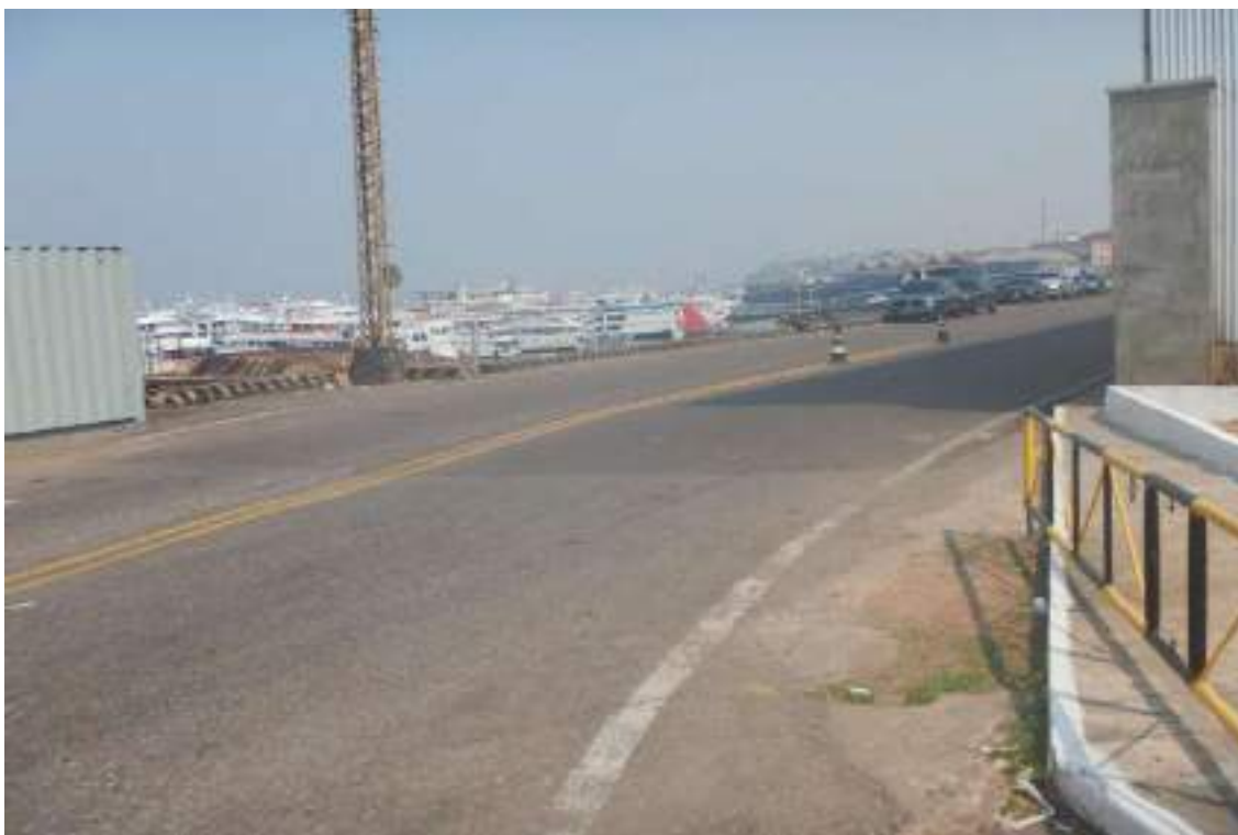
FIGURA 46 – POSTO DE CONTROLE P-4.1 E INÍCIO DA PISTA DE ROLAMENTO. FONTE: UNILIVRE, SETEMBRO, 2023.
